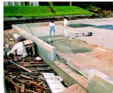
O Polidesportivo do Parque Municipal está a ser totalmente remodelado.
