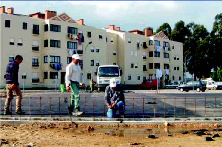
Polidesportivo da Teixugueira em construção
