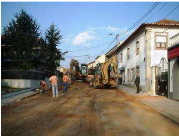
Obras na EN 1-12
